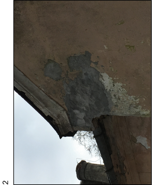
usunięcie splekanych i odspojonych tynków
