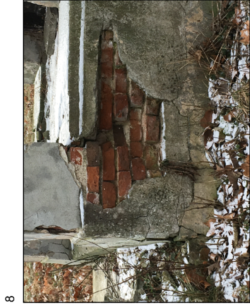
usunięcie splekanych i odspojonych tynków
