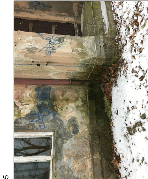
usunięcie tynków pokrytych koloniami glonów i pleśni
