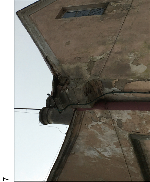
usunięcie splekanych i odspojonych tynków
