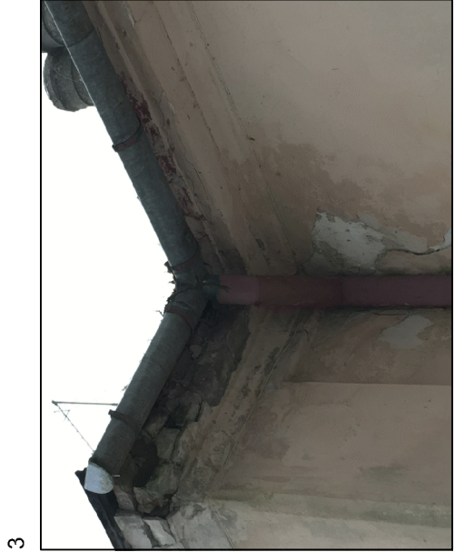
usunięcie splekanych i odspojonych tynków
