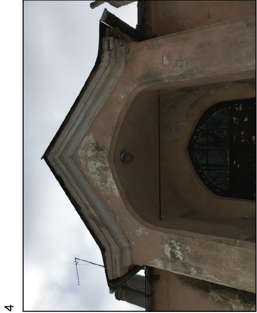
usunięcie splekanych i odspojonych tynków
